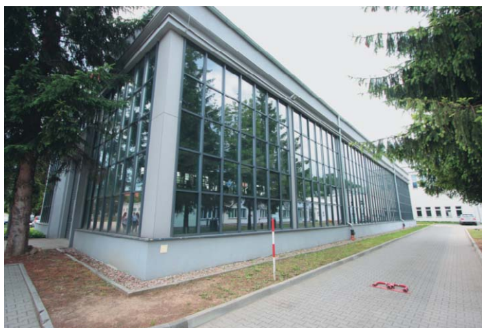
Wyremontowana hala maszyn Instytutu Inżynierii Rolniczej
