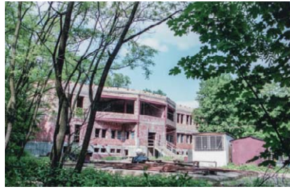
Budowa Wydziału Biologii i Hodowli Zwierząt
