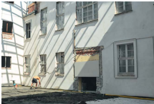
Tak wyglądała budowa patio, dzisiaj jednego z reprezentacyjnych miejsc na UPWr
