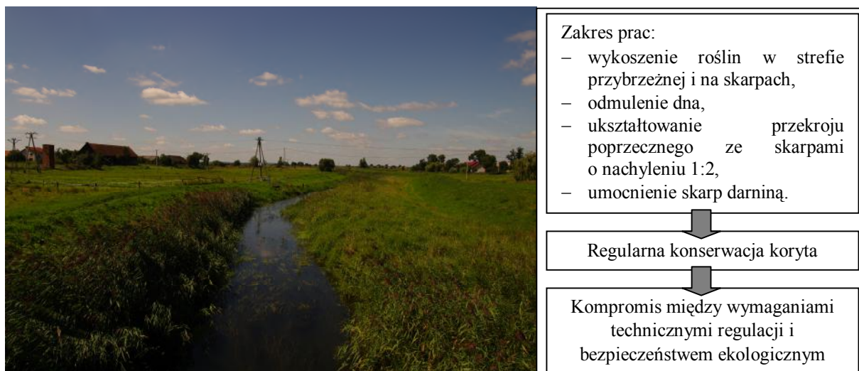
Rys. 3. Odcinek badawczy, spełniający jednocześnie kryteria techniczne i przyrodnicze regulacji
