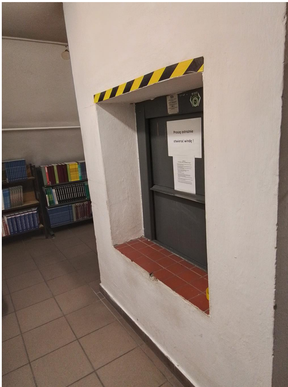
Fotografia nadszybia windy na I piętrze.
